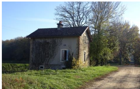
Maison du garde-barrière
